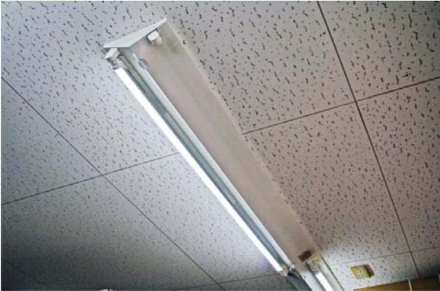
配線工事後は、2灯式器具の1灯を外しても点灯が可能なので、蛍光灯の使用本数を減少させる事ができます。
